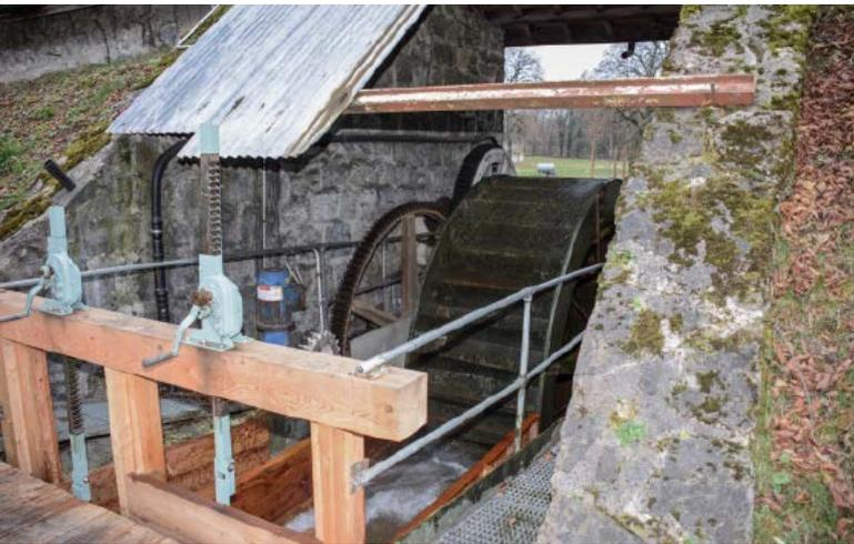
Wasserkraft betreibt die Läufermühle. Reguliert wird die Wassermenge von Hand mittels der Drehkurbel.
